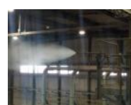
飛散防止措置 (工水噴霧)
