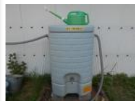
雨水貯留タンク
