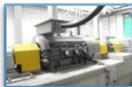
2号炉発電機 発電能力 : 500kW
