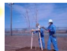
悔いなき杭打ち!
